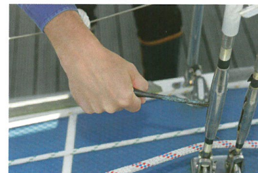
Pozor na poškození takeláže přetažením napínačů.
